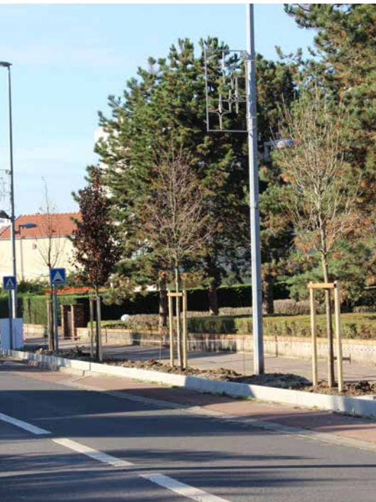
Travaux d'aménagement en cours avec la plantation de nouvelles essences.
