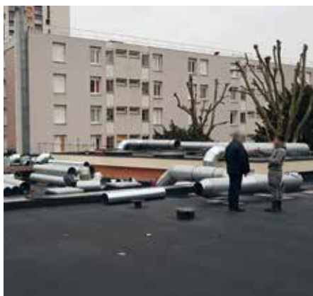
Réfection de l'étanchéité du Centre socio-culturel des Chênes
